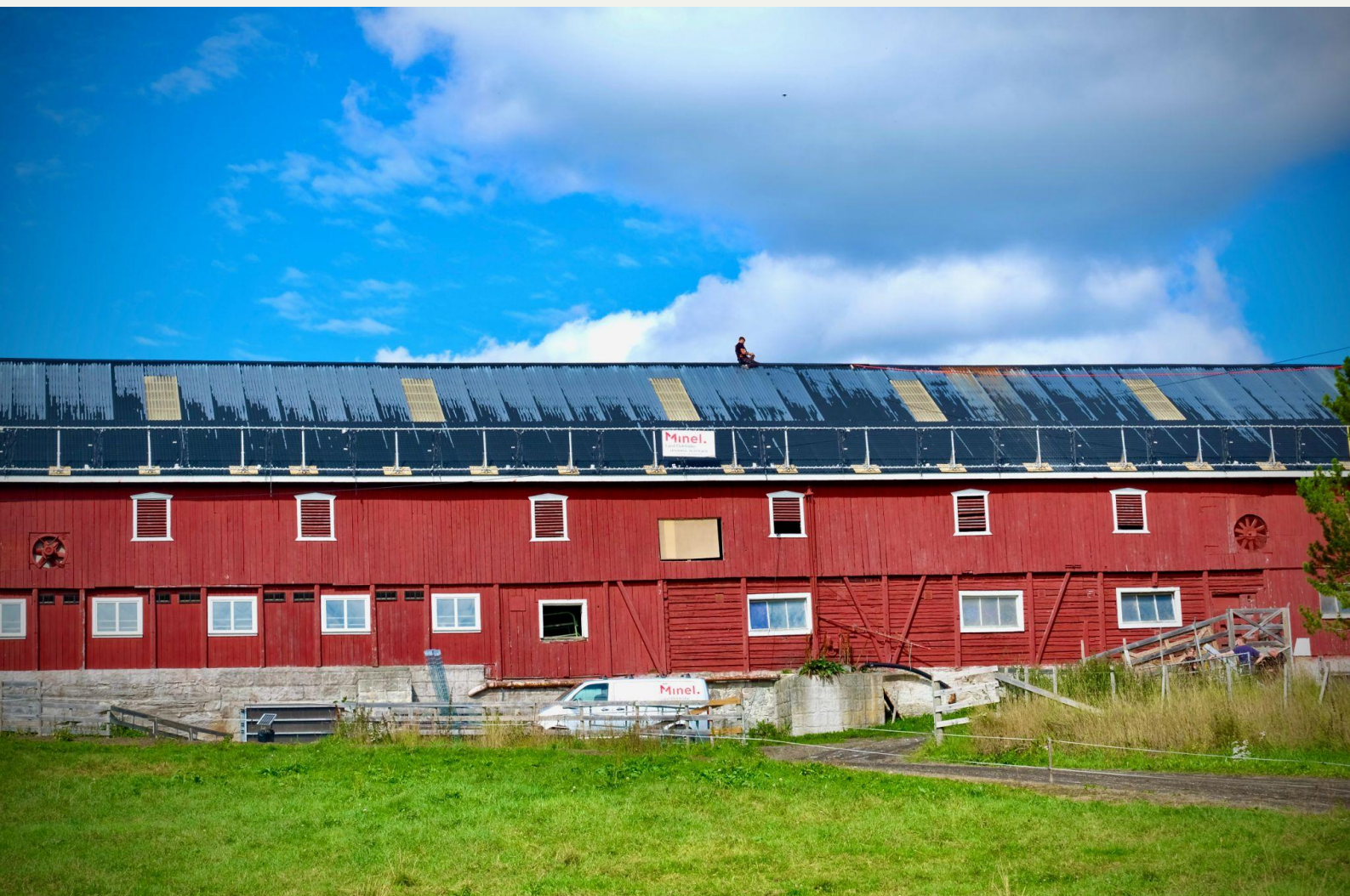
Sikring av blikktak ved solcelle installasjon på låve
