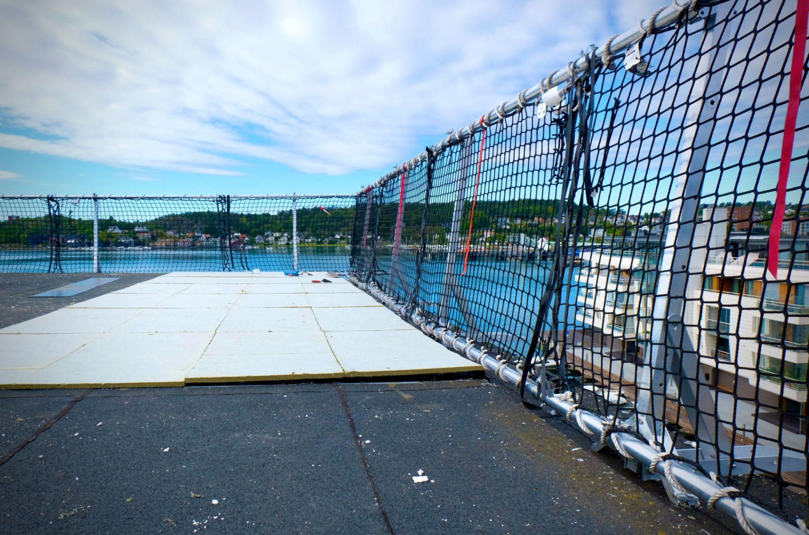
20 meter sikring av papp tak ved takarbeid i forbindelse med rehabilitering
