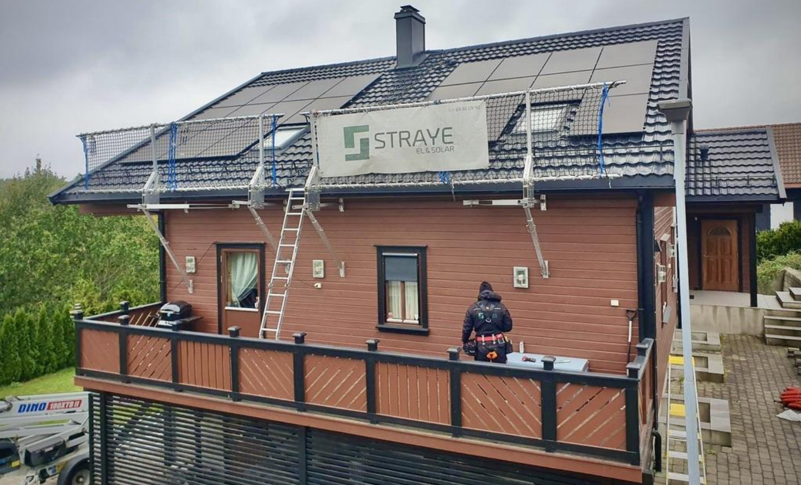
10 meter veggmontert sikring av takkant med Wall-fix for solcelle installasjon
