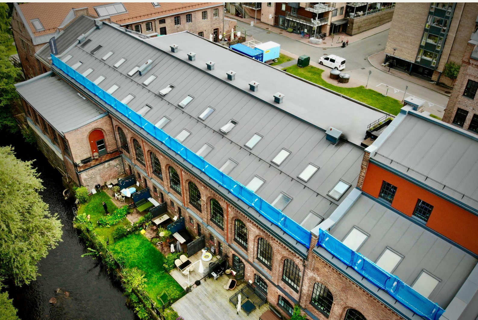
50 meter sikring av takkanten på membran-tak ved utskifting av Velux tak-vinduer.
