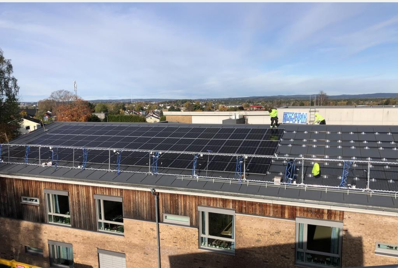
35 meter sikring av lett tak for solcelle installasjon
