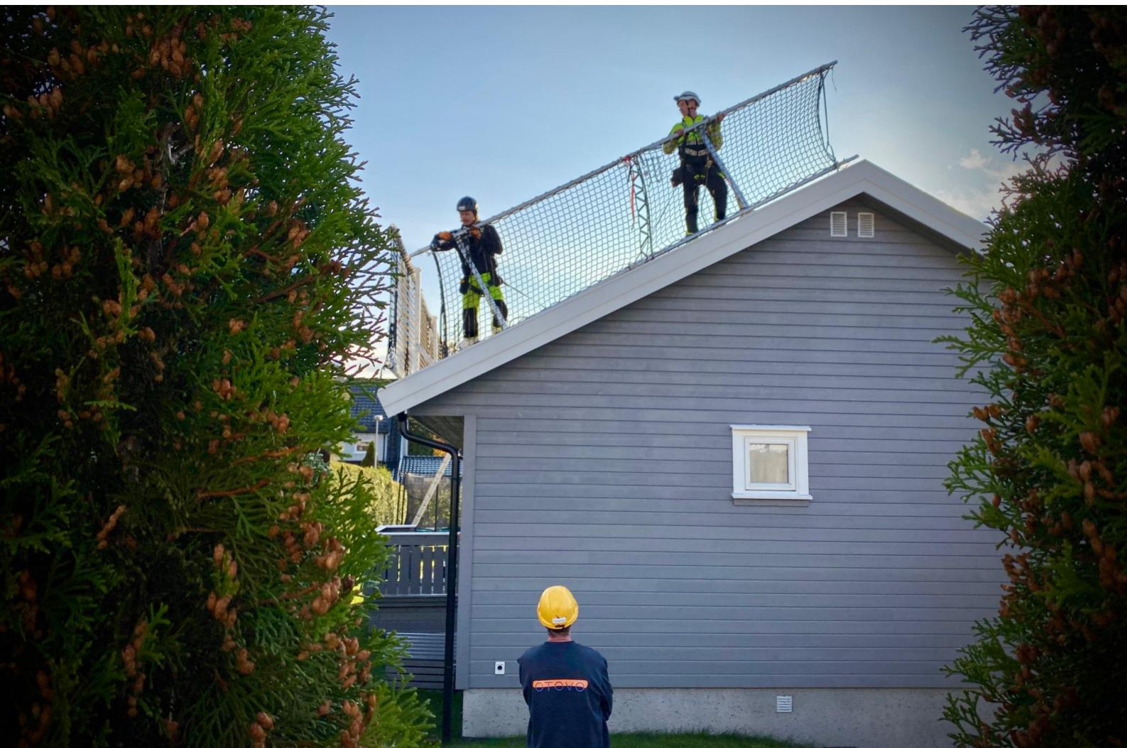
20 meter sikring av langside og kortside for solcelle installasjon på enebolig
