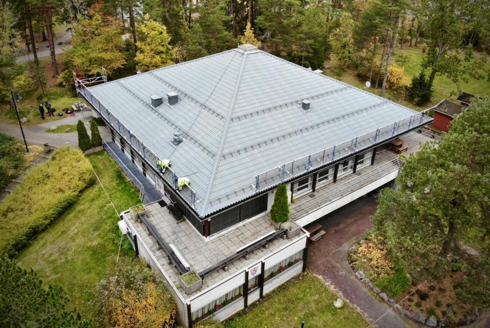
50 meter sikring av plania tak for solcelle installasjon
