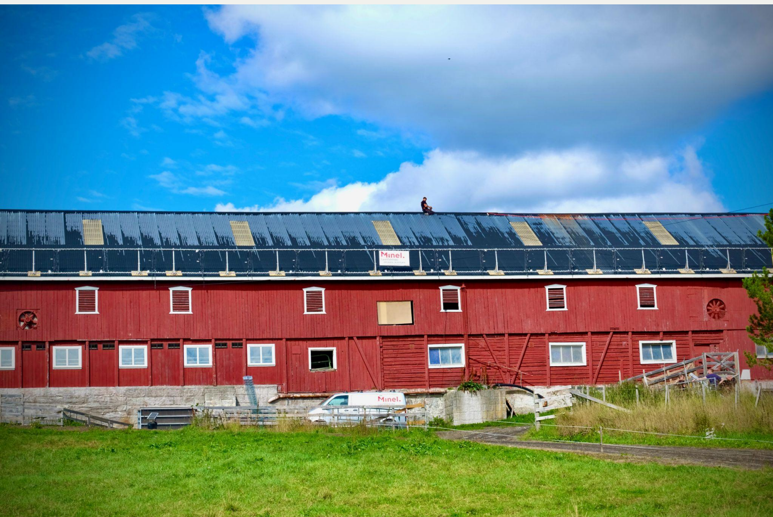
50 meter sikring av blikktak ved 125 kWp solcelle installasjon på låvetak
