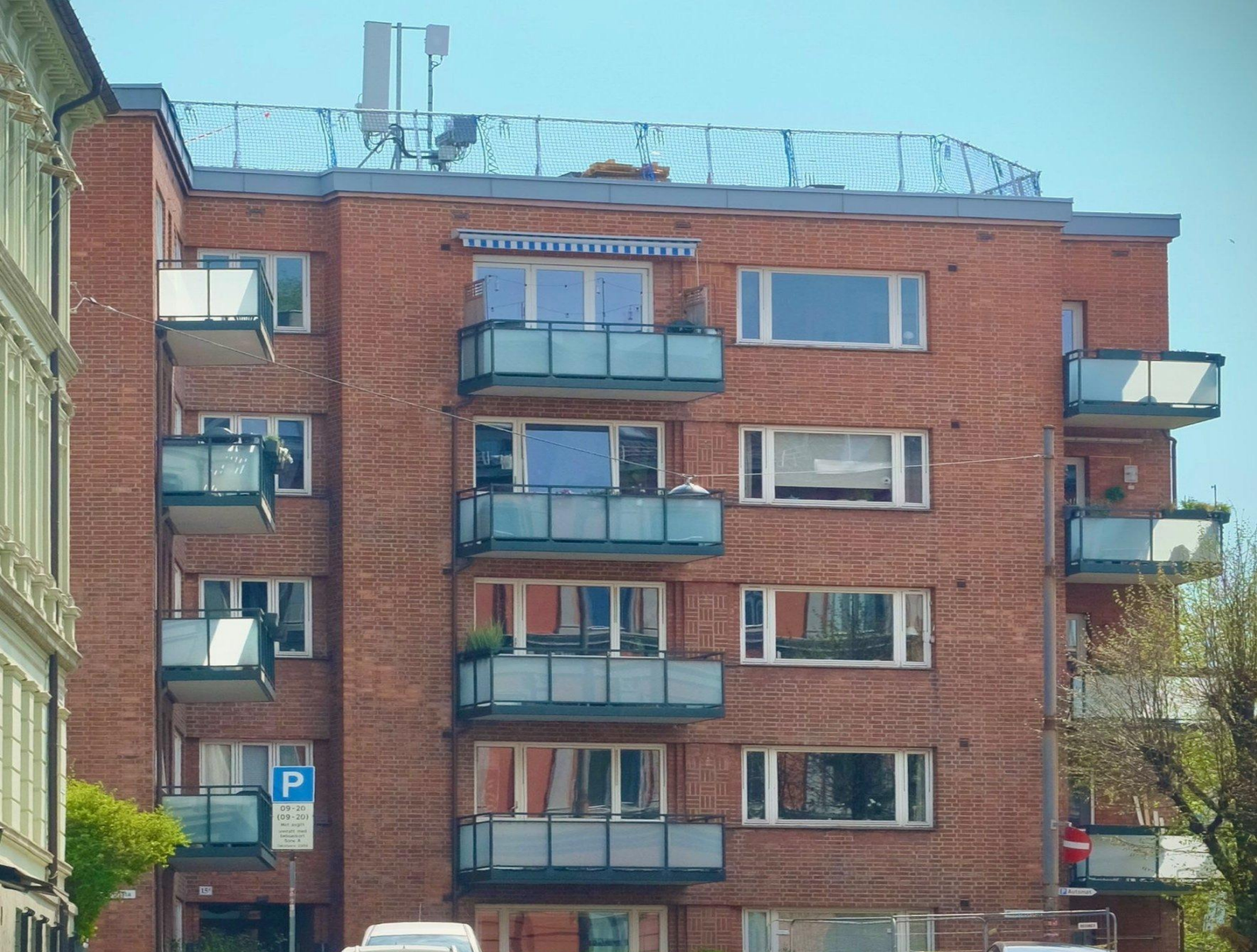
75 meter sikring av takkant ved montering for telecom
