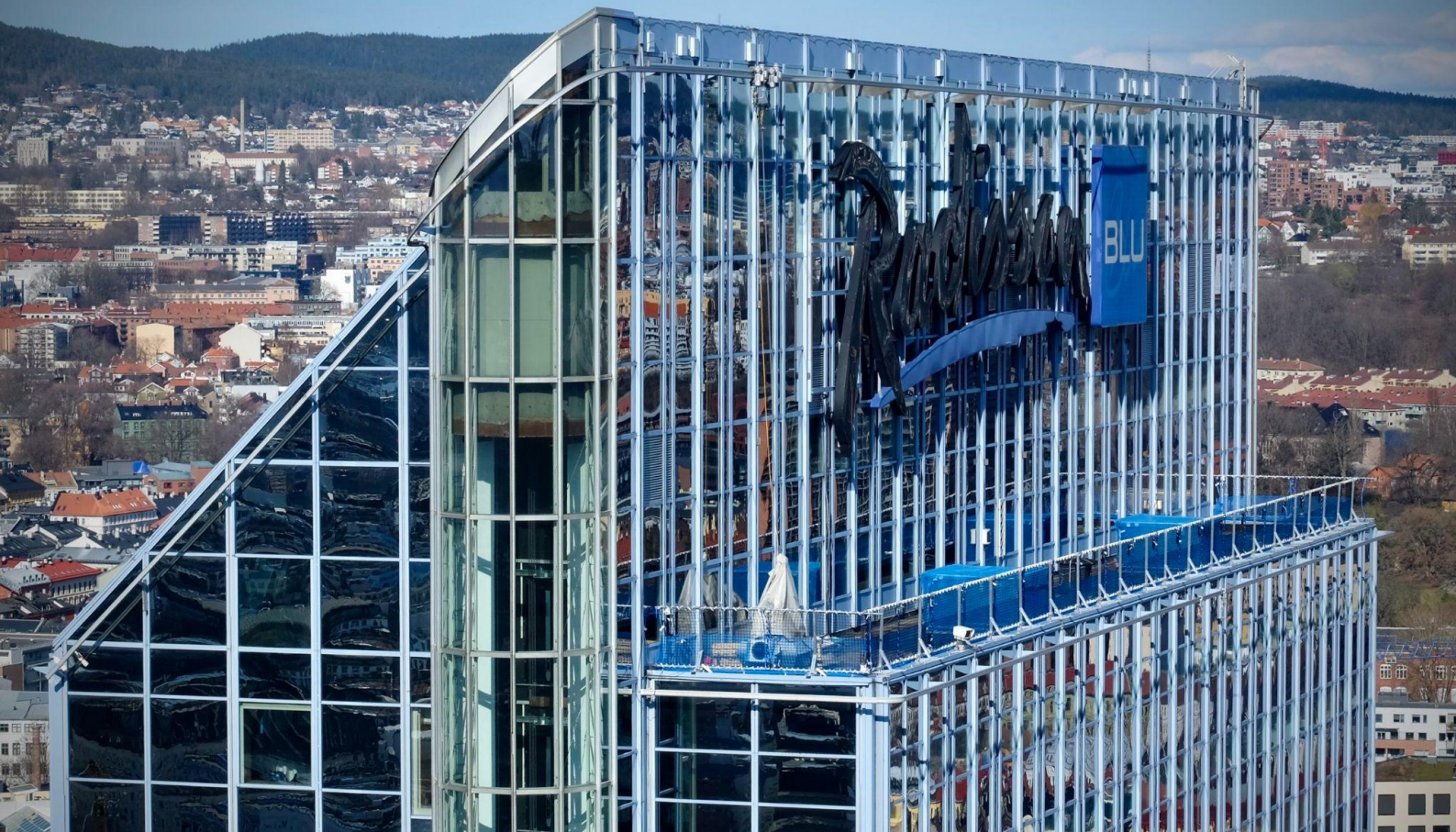
60 meter gavl sikring av takarbeid ved bygging av takterasse på Oslo Plaza 110 meter over bakken.
